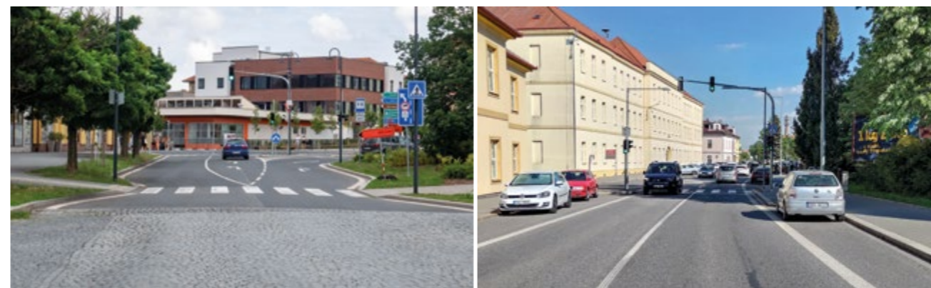
Stavební úpravy, kde v rozporu s ČSN 73 6110 nebyl zřízen dělený přechod pro chodce, ale došlo k zúžení vozovky
