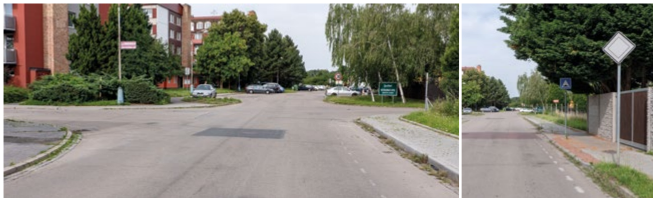
Nejasná přednost v křižovatce kvůli absenci vodorovného značení a svislé znače nesmyslně předsunuté o 45 m
