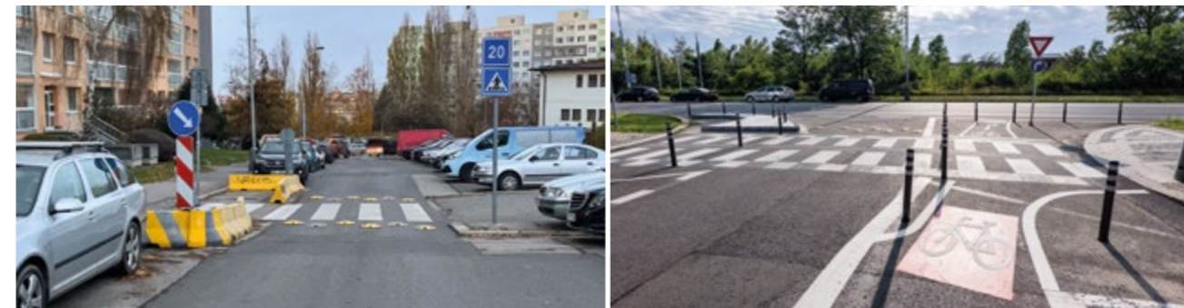
Trvale dočasné, přeznačované a nevzhledné zajištění rozhledů na přechodu, které „omezilo parkování“
