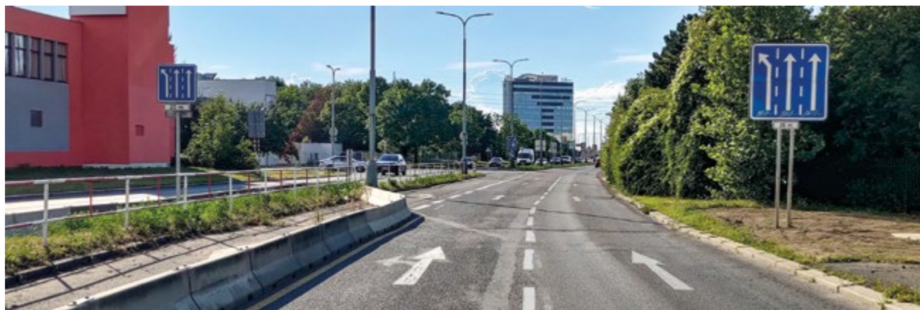
Srovnání základní a zmenšené velikosti SDZ IP 19 Řadící pruhy na sběrné komunikaci
