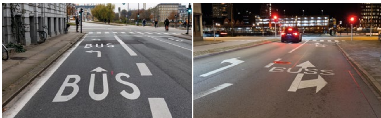
Povolený směr pro některá vozidla vyznačený pouze pomocí vodorovného značení (Dánsko + Švédsko)
