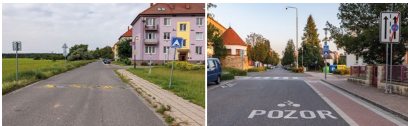
Zbytečné označení zpomalovacích polštářů značkou; zpomalení vozidel navíc popírá vyznačenou hlavní pozemní komunikaci na nedaleké křižovatce
