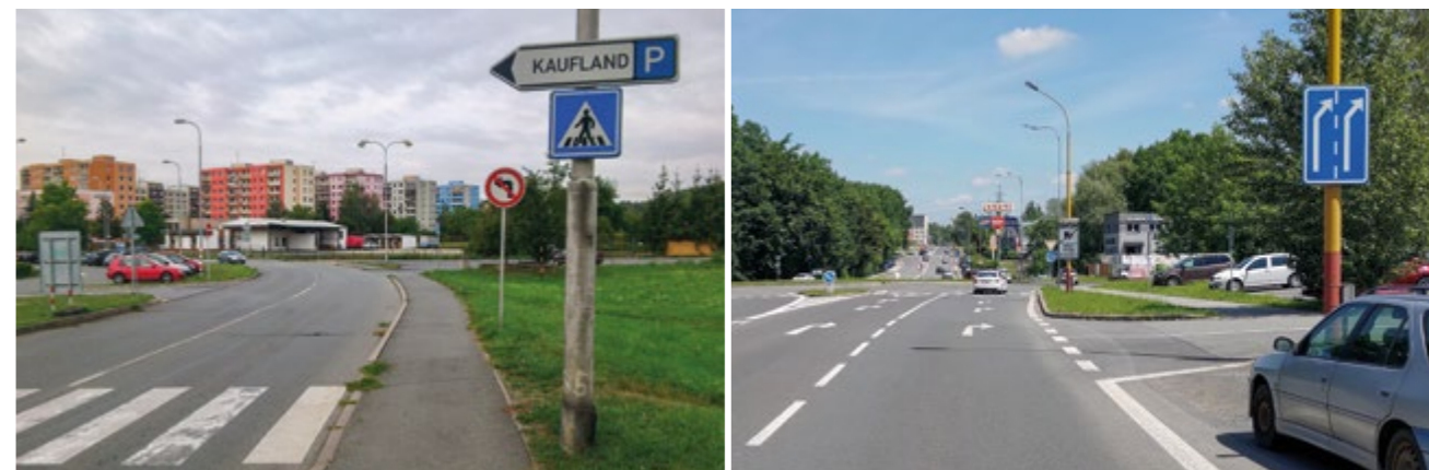
Předčasně umístěná směrovka na parkoviště navádí do zákazu odbočení
