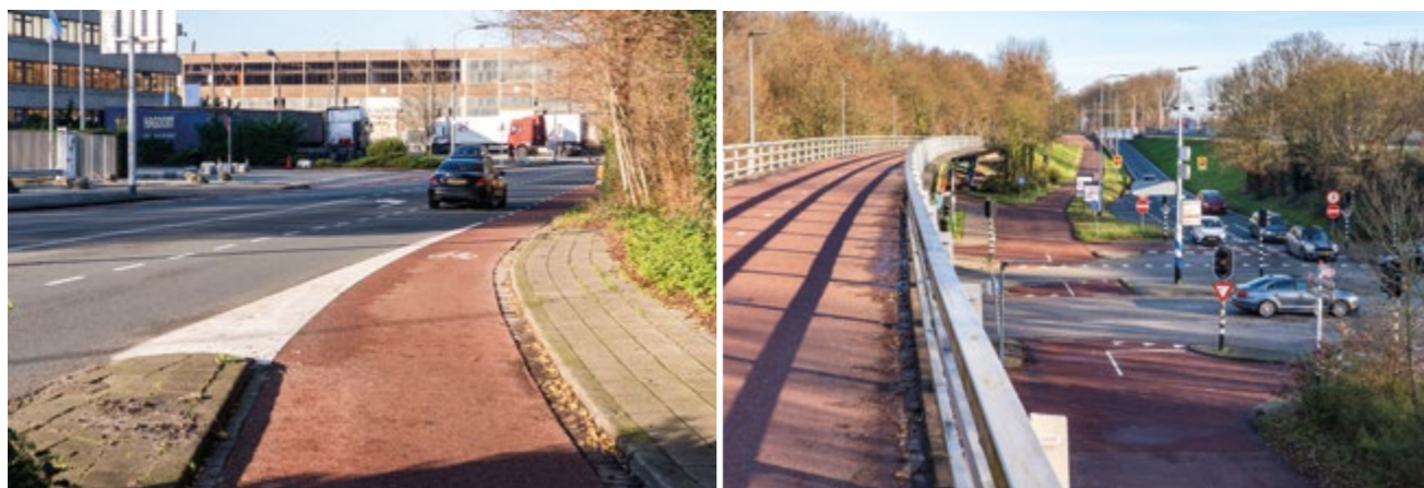
Pruhy a stezky pro cyklisty díky systematickému zbarvení nevyžadují svislou značku (Nizozemsko)
