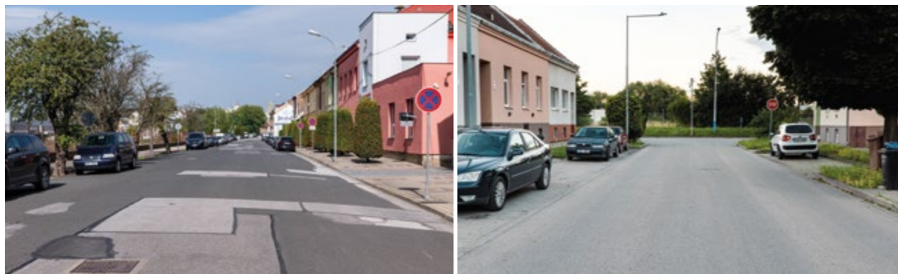
Chybějící vyznačení pruhů na obslužných komunikacích s šířkou 6,0 m a více
