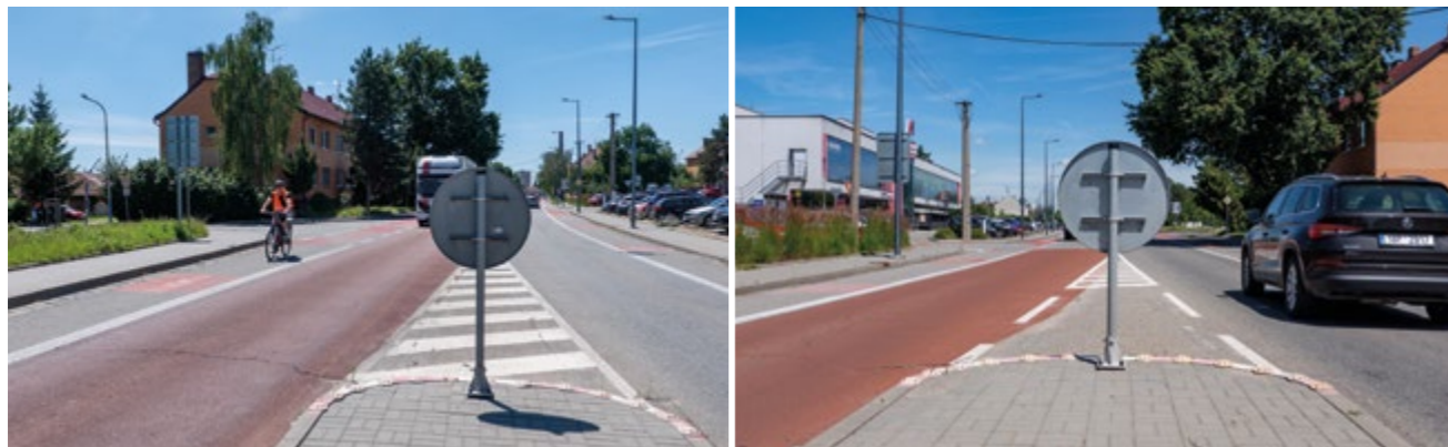
Zacloněný rozhled z ostrůvku z výšky očí dospělého (vlevo) i dítěte (vpravo) zakrývá příjezdějící nákladní vozidla
