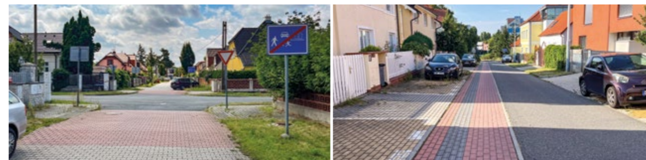
Oddálení zpomalovacího prahu zbytečně prodlužuje pěší vazbu; zároveň je zde nadbytečně značka přednosti
