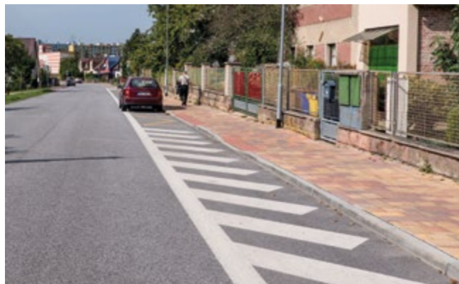
Zbytečná plocha vozovky plýtvá prostorem
