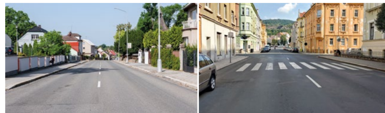
Dlouhodobě existující naddimenzovaná šířka komunikace a její rizika „nevadí“, protože se jedná o současný stav
