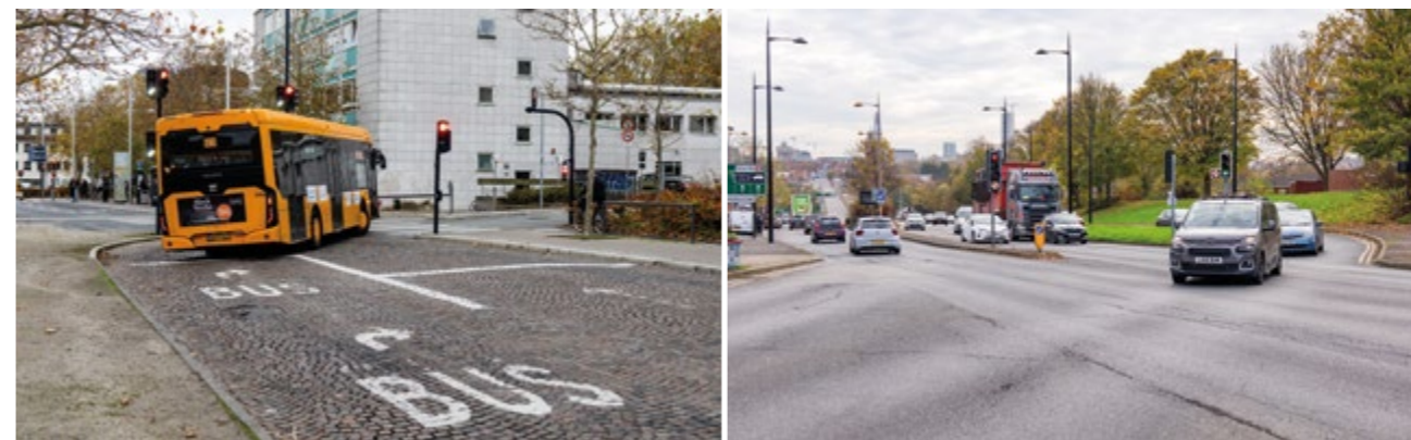
Odbočování vozidel přes směr přímo zajišťuje lepší průjezdnost (Dánsko + Velká Británie)
