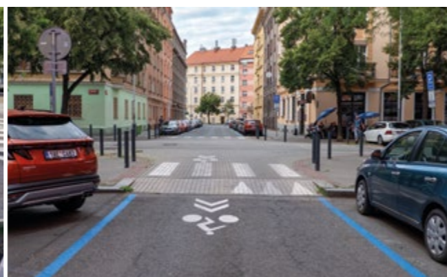
Vhodná stavební úprava zmenšení křižovatky
