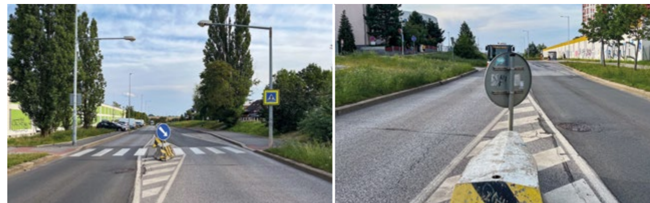
Omezený rozhled na nestavebním dělicím ostrůvku
