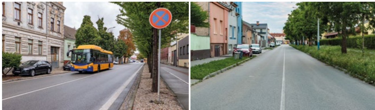
Naddimenzovaná šířka komunikace i jízdních pruhů na městské komunikaci
