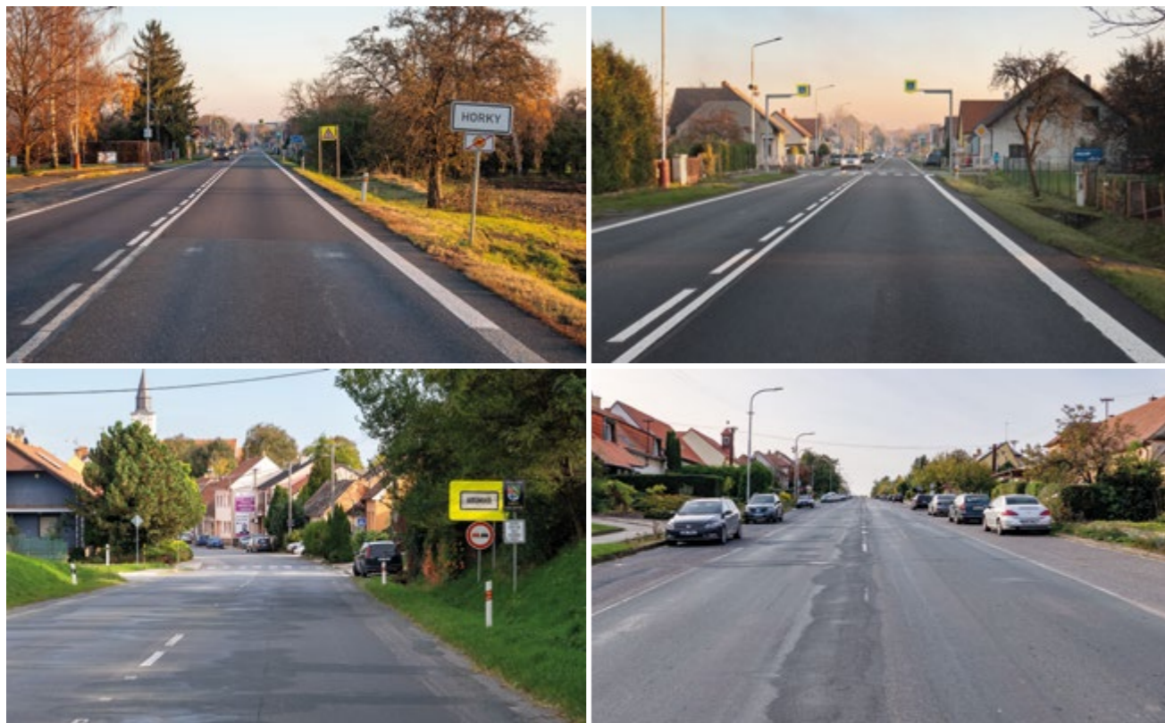
Problematické řešení průtahů obcí, které jsou příliš široké a svádí k rychlejší jízdě
