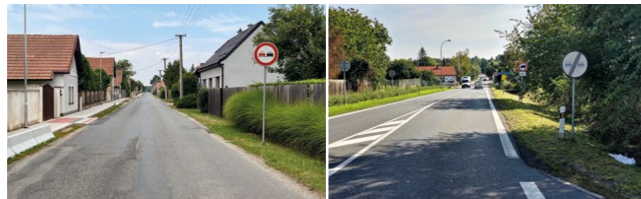
Zákaz předjíždění se v intravilánu zpravidla nepoužívá; v obou případech navíc vytváří nesoulad s vodorovným značením
