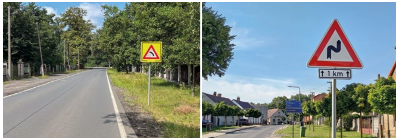
Předčasně a zbytečně umístěné značky zatáčky
