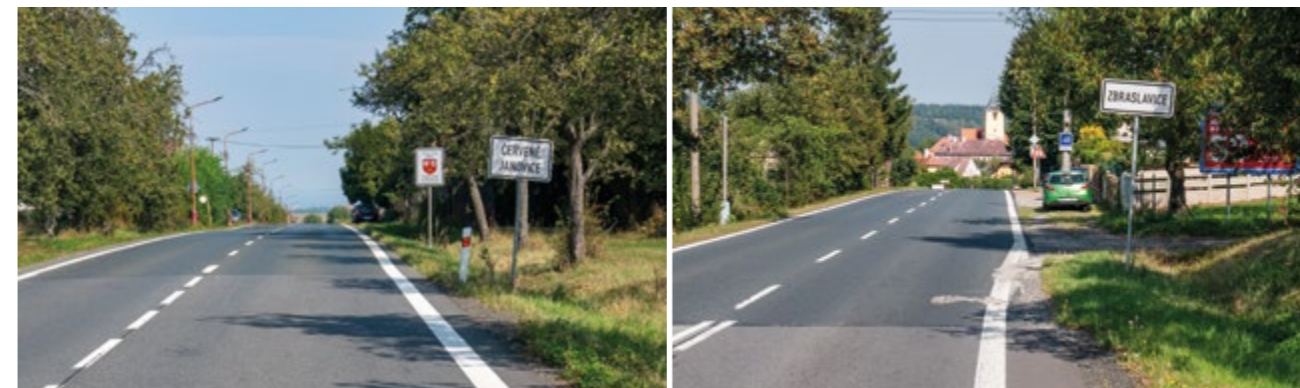
Nesprávné řešení – zachování šířky, nebo dokonce rozšíření jízdních pruhů v obci
