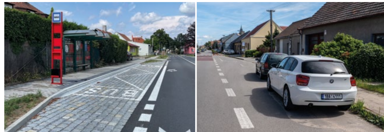
Nesprávné užití vodorovného značení umožňuje legální stání v nájezdech
